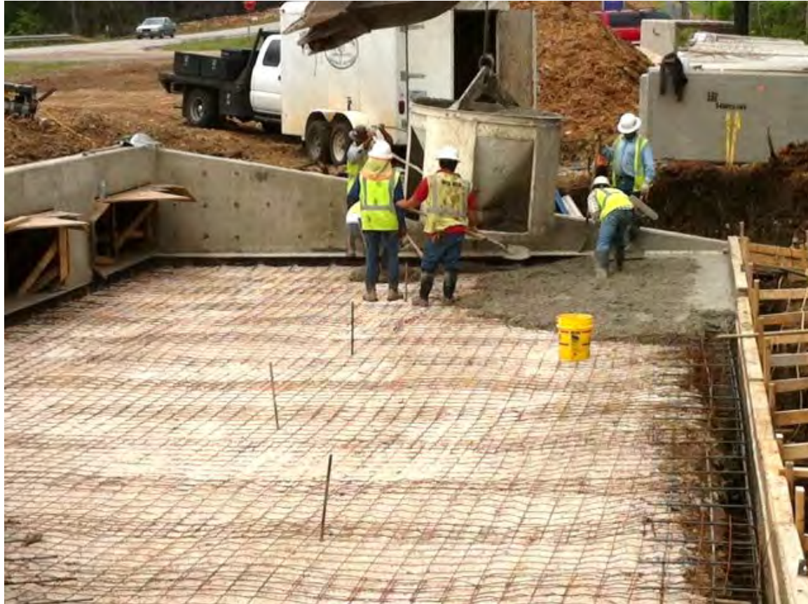
Pouring apron for Culvert E
